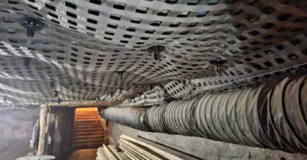
Zabezpieczenie stropu geosiatką górniczą bazaltową
