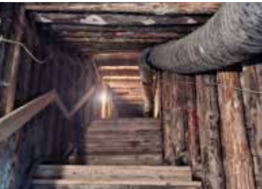
Schody w pochylni łączącej poziomy III i IV
